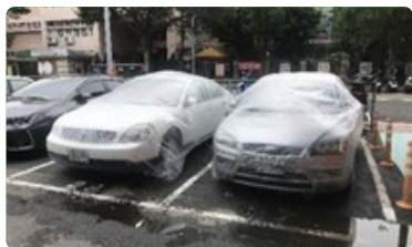
結構體澆置樓版期間，進行工地周邊道路及停放汽車保護，減少周邊車輛汙染。
