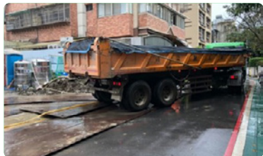
於工地的車行路面、堆料棄土區、傾斜作業區、裸露地面等區域進行灑水噴霧，防止塵揚。
