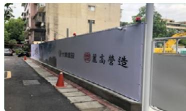
工地周界築有圍籬及行人安全廊道，防止塵土汙染及行人安全。
