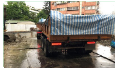
運送廢土過程中使用密封車存放濕土或於運送乾土時於車體覆蓋防塵膠布，防止塵土汙染。
