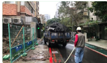
配置洗車台以及高壓沖洗設備，避免車輛運送廢土或其他污染物時將髒汙帶出工地造成鄰近社區地面與空氣汙染。
